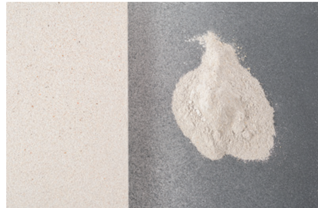
Minero Light - Échantillons de mortier dégradé dans la masse.
